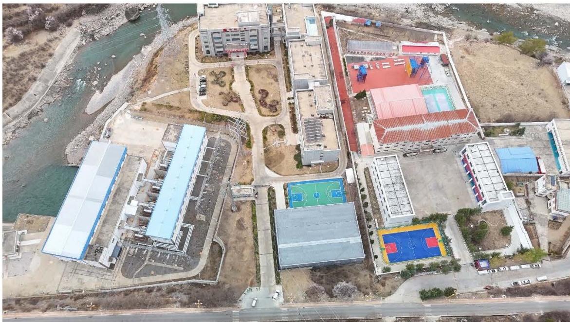
图 2.1-2 乡城县硕曲河硕中水电站变电站现状
