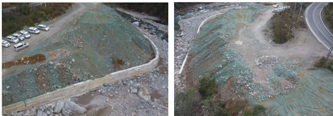
图 3.2-5 新电 8#弃渣场过程影像资料
