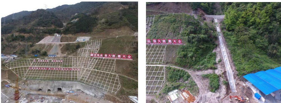
图 6.6-1 厂房边坡及排水设置情况
