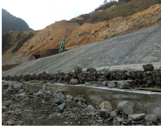
电 1#渣场 A 区渣场挡墙修复后
