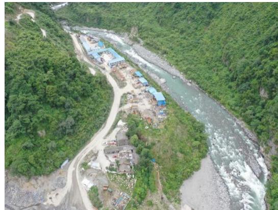
电 1#弃渣场 B 区
