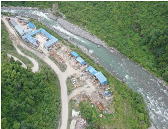
电 1#弃渣场 B 区
