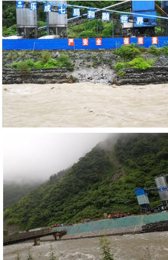
图 3.5-2 施工营地挡墙修复前后情况
