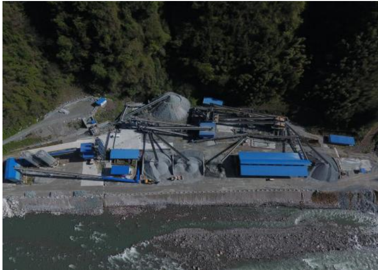
图 6.6-2 砂石加工系统外侧设置挡墙防护
