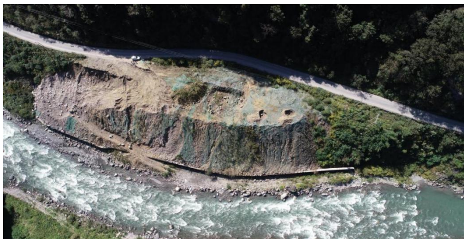
图 3.2-2 新电 2#弃渣场过程影像资料
