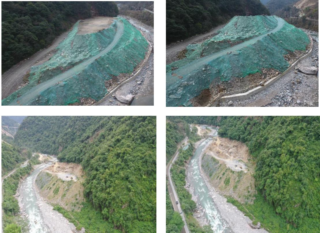
图 3.2-7 新电 10#弃渣场过程影像资料
