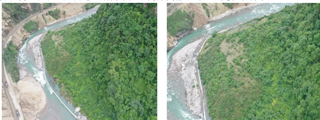
图 3.2-6 新电 9#弃渣场过程影像资料
