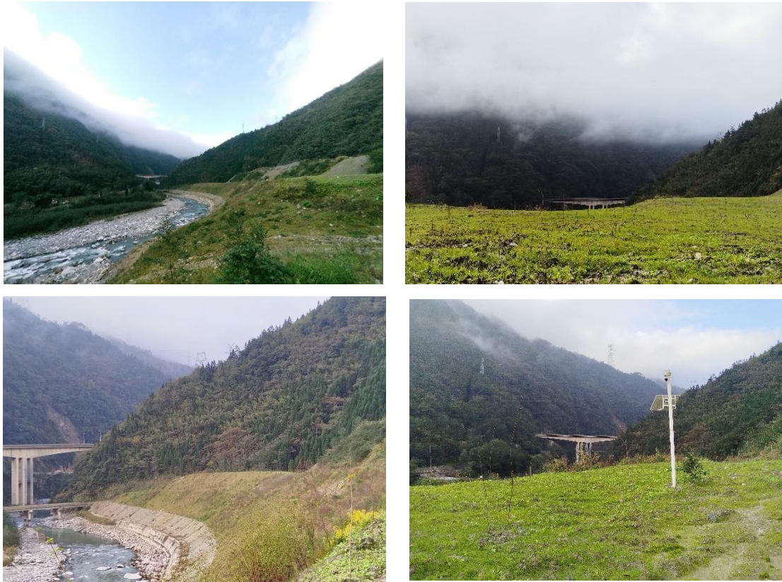
图 3.2-4 电 4#弃渣场现状照片
