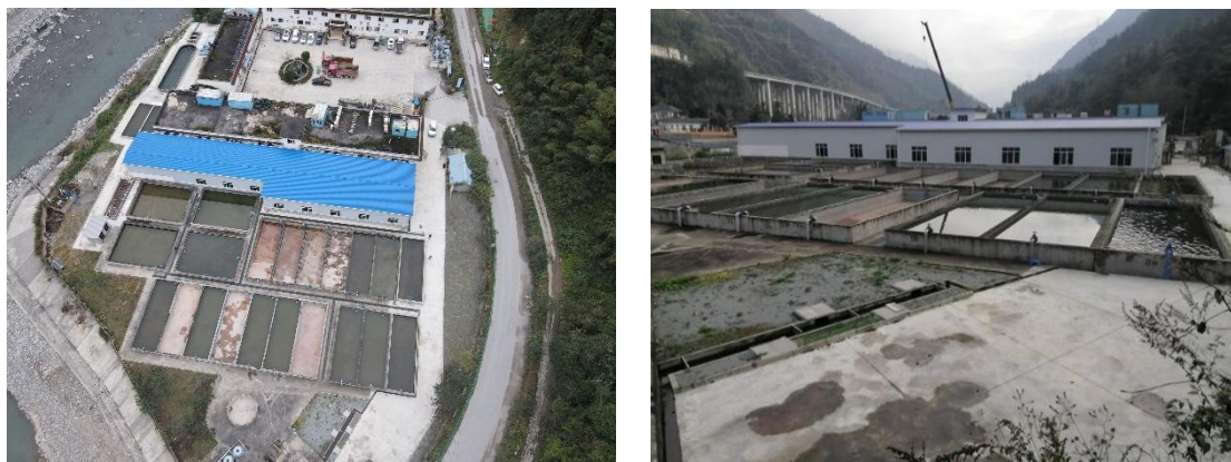
图 3.2-3 新电 3#弃渣场现状
