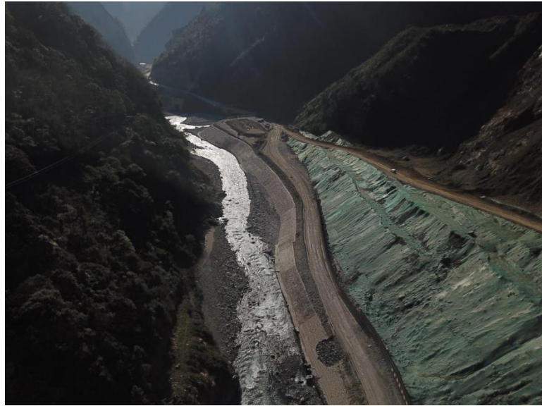
电 1#弃渣场 A 区
