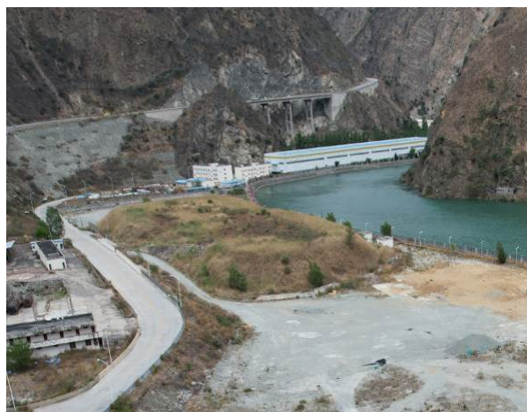
(27)3#表土堆存场 (2022 年 3 月)
