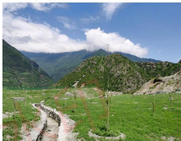
(12)江咀料场 B 区排水沟 (2020 年 8 月)
