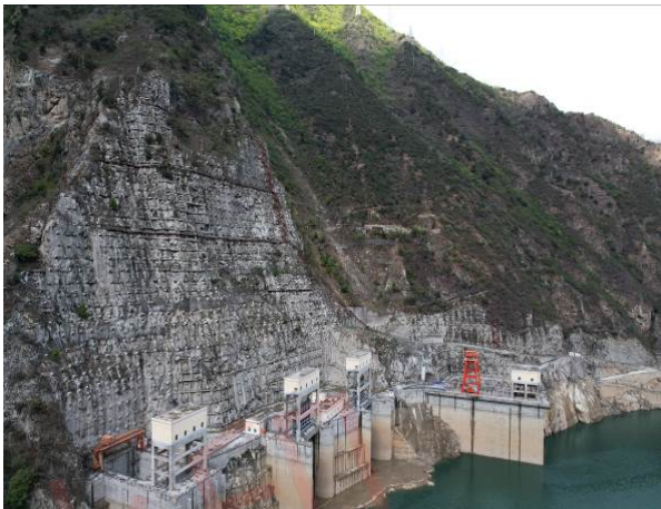
(2)泄洪洞进口边坡（2024 年 7 月）
