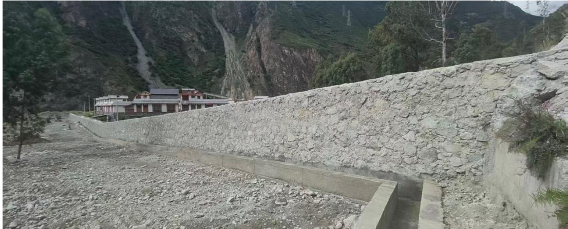
图 9.1.5 已实施完成的拦挡墙防护工程示意图
