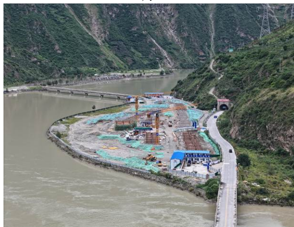
牛棚施工场地建设移民安置点（2024 年 7 月）
