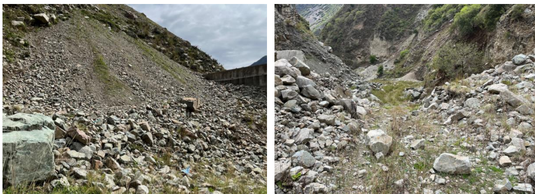
图 9.2.4 2#拦渣坝上游沟道内松散堆积体现状
