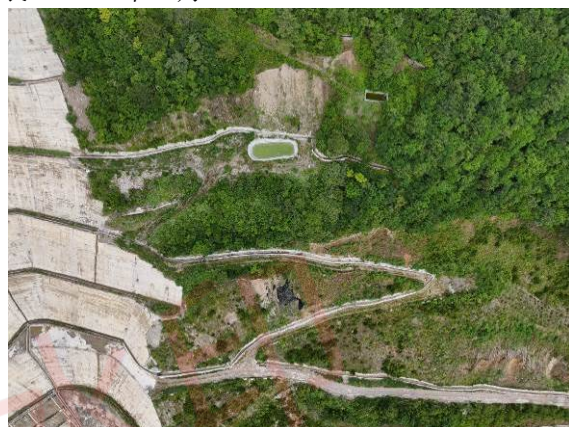
(20)汤坝料场上部排水沟（2024 年 7 月）
