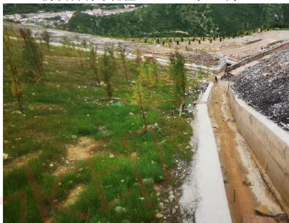
汤坝料场排水沟（2025 年 10 月）
