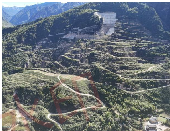
(16) 汤坝料场恢复面貌 (2025 年 10 月)
