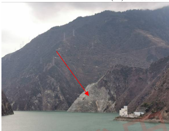
(15)响水沟料场 (2023 年 4 月)
