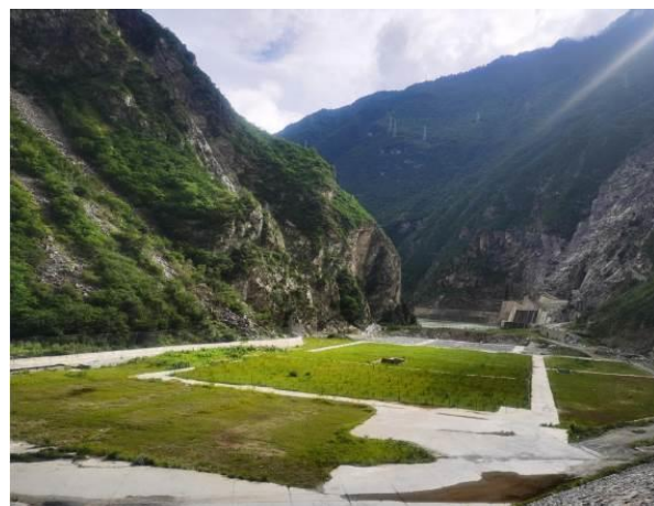
(6) 大坝围堰绿化 (2024 年 9 月)
