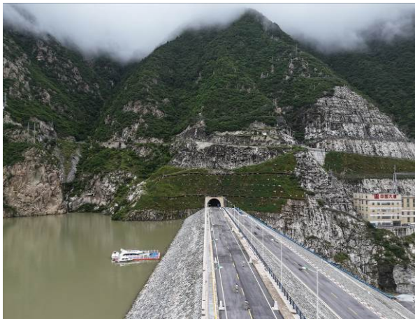
(1)大坝坝顶现状（2024 年 7 月）
