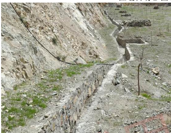
江咀料场 A 区排水沟 (2022 年 3 月)
