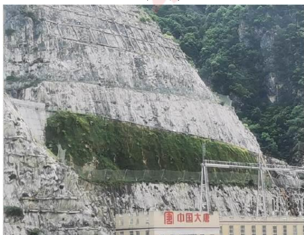
(5) 开关站边坡绿化 (2024 年 7 月)
