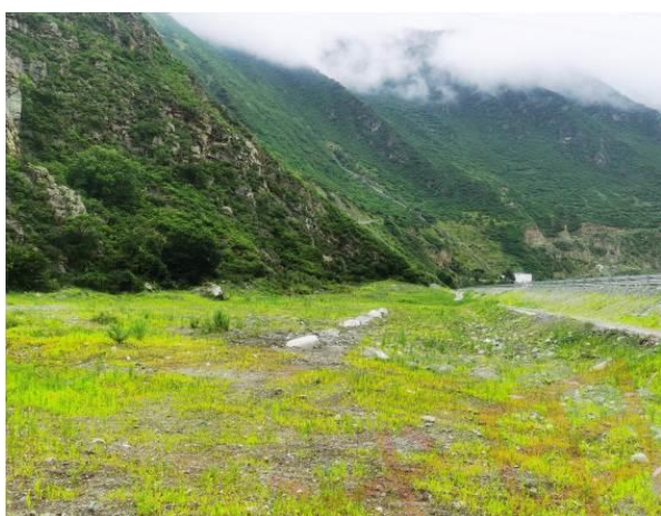
(28) 洞挖渣料回采场 1 (2024 年 7 月)
