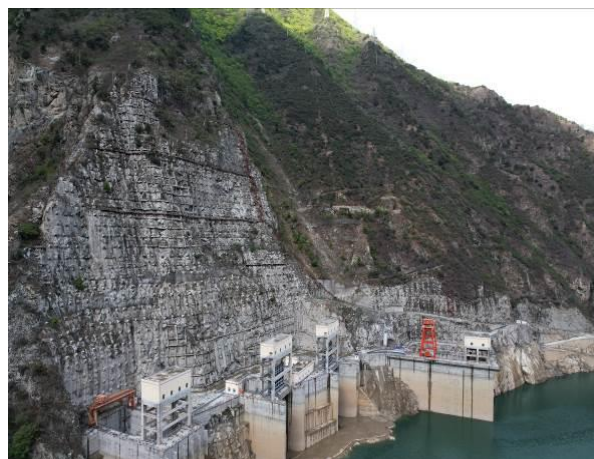
(2) 泄洪洞进口边坡 (2024 年 7 月)
