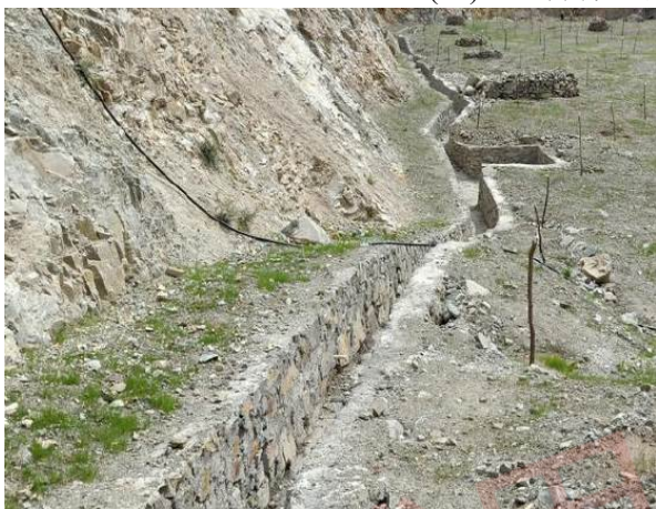
(11)江咀料场 A 区排水沟 (2022 年 3 月)
