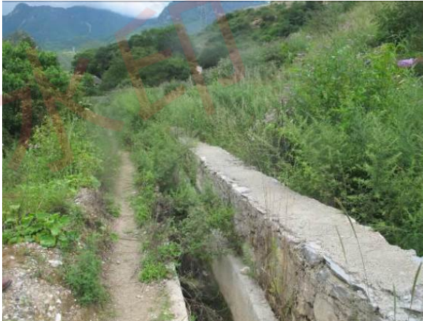
1#表土堆存场挡护及排水（2023 年 8 月）
