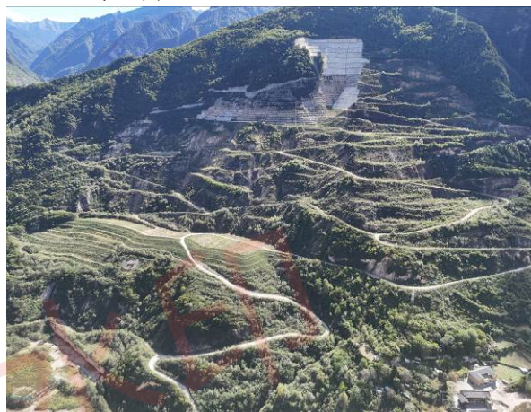
(16)汤坝料场恢复面貌 (2025 年 10 月)
