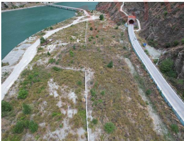
牛棚施工场地平整绿化（2023 年 4 月）
