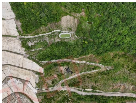
(20) 汤坝料场上部排水沟 (2024 年 7 月)
