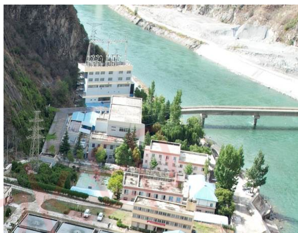
施工变电站（2023 年 8 月）
