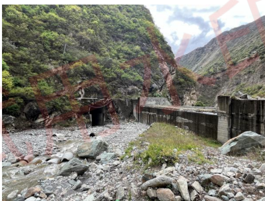
9.2.3 导洪墙及排水洞目前现状
