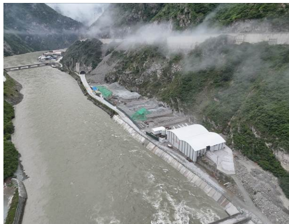
下游混凝土拌合系统现状（2024 年 8 月）
