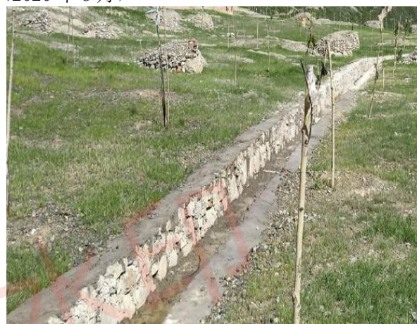
江咀料场 B 区排水沟 (2022 年 3 月)
