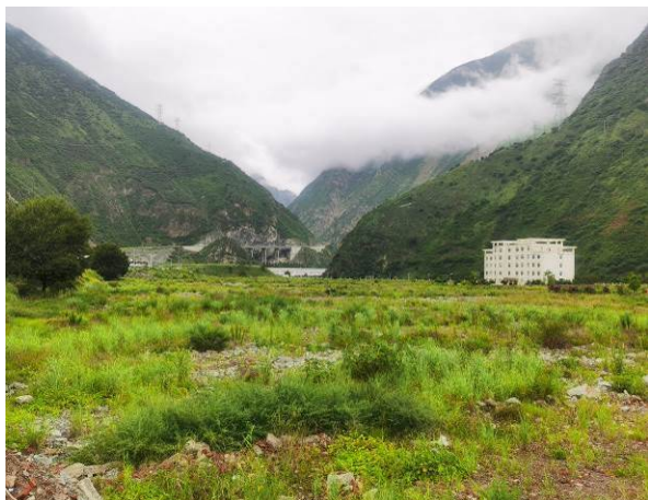
野坝村施工区 3（2025 年 9 月）
