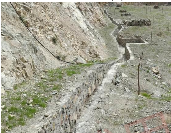
(11) 江咀料场 A 区排水沟 (2022 年 3 月)
