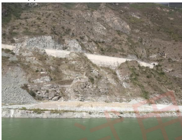
(3) 下游混凝土拌合系统场地复垦及平整 (2023 年 8 月)
