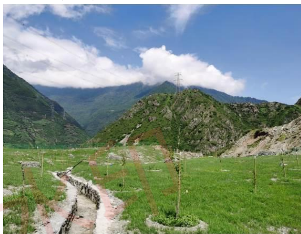
(12) 江咀料场 B 区排水沟 (2020 年 8 月)
