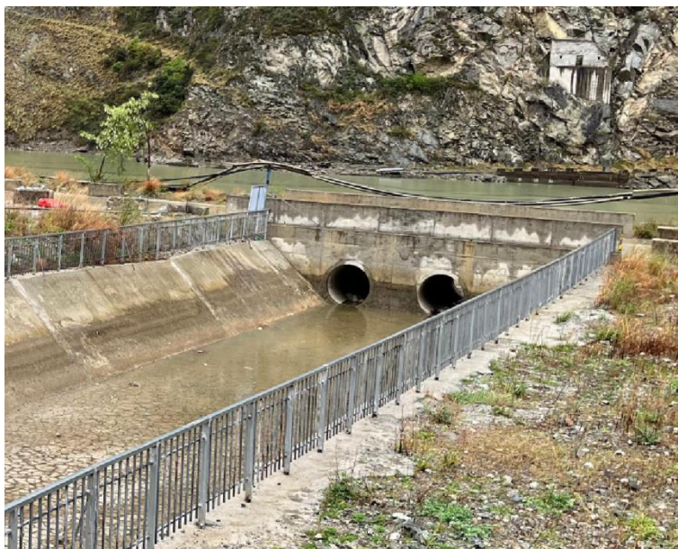
图 9.2.7 排洪渠末段圆形涵管
