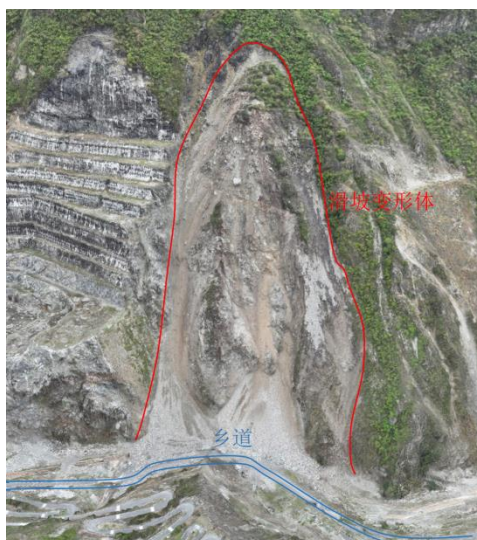
图 9.2.6 滑坡变形体现状
