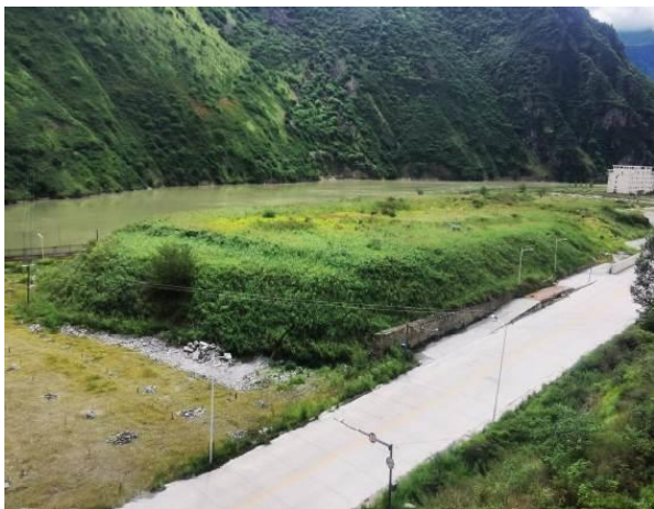
(26) 2#表土堆放场 (2024 年 7 月)
