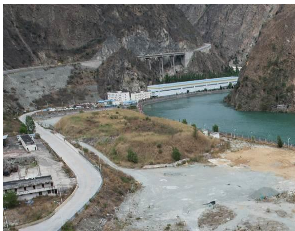
(27) 3#表土堆放场 (2022 年 3 月)
