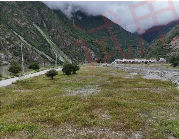
洞挖渣料回采场 1（2025 年 9 月）
