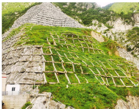
图 18 进水口喷播绿化面貌
