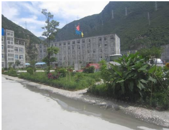
图 74 施工期野坝营地绿化措施
