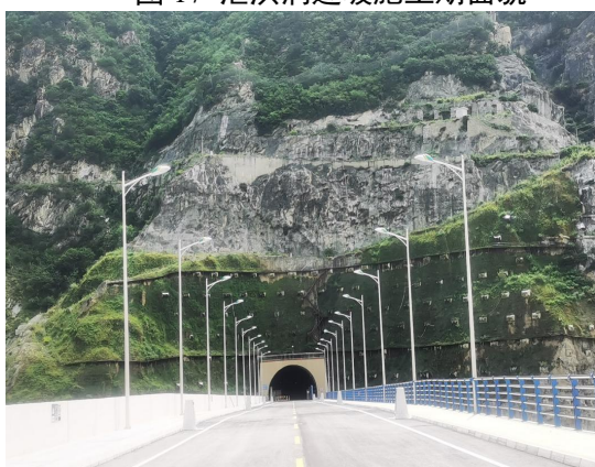
图 19 左坝肩喷播绿化面貌
