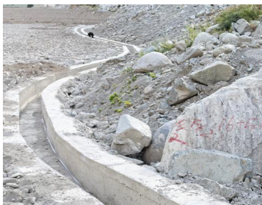
图 33 磨子沟渣场排水沟
