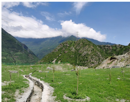
图 50 江咀料场 B 区施工期面貌 1
