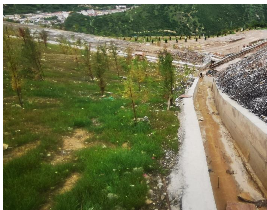
图 58 汤坝料场排水沟
