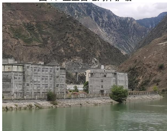
图 72 野坝施工营地临河护坡
