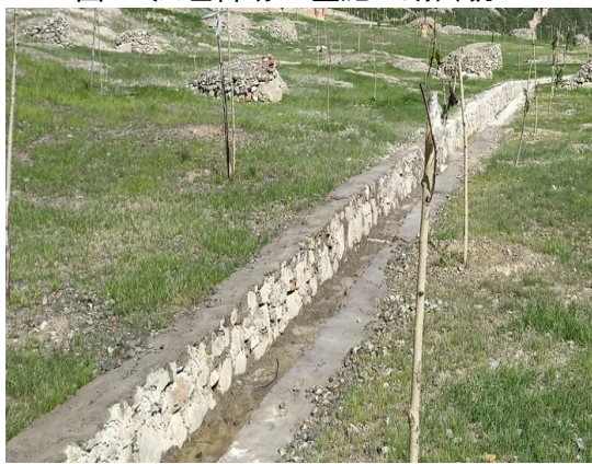
图 55 江咀料场 B 区排水沟
