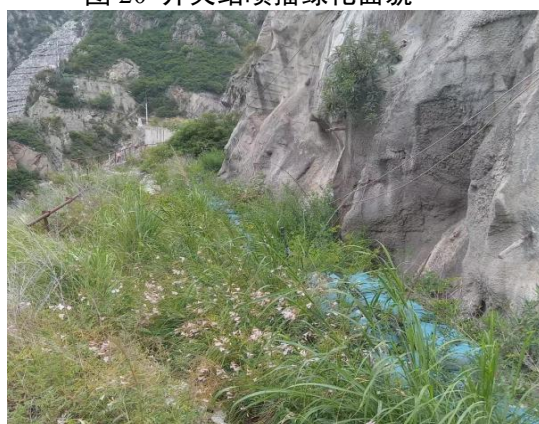
图 22 左坝肩边坡马道绿化措施
