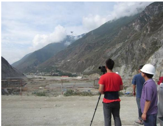
图 3 大坝区工程无人机低空遥感监测
