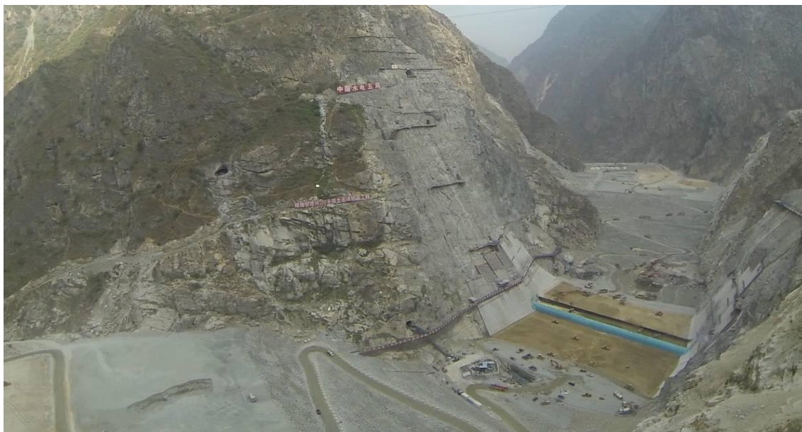
图 11 建设期坝区无人机低空遥感航拍面貌
