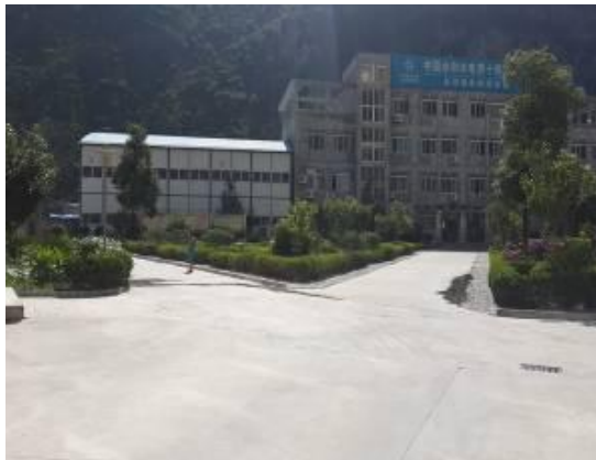
图 73 施工期野坝营地绿化措施
