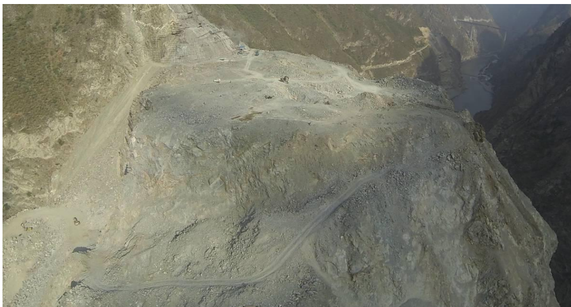
图 14 建设期响水沟料场无人机低空遥感成像面貌
