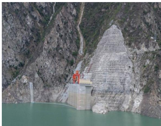
图 16 进水口边坡蓄水期面貌
