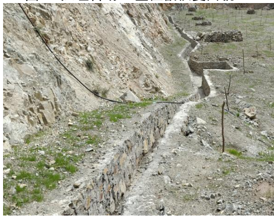
图 56 江咀料场 A 区排水沟
