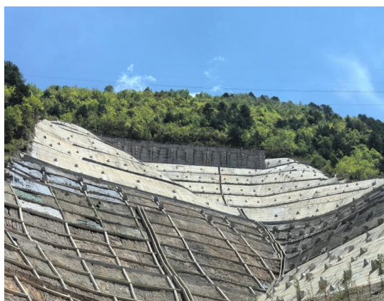
图 57 汤坝料场工程防护措施
