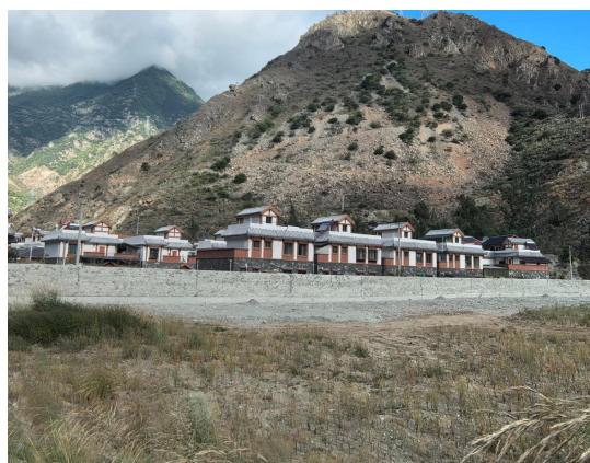
图 34 磨子沟渣场浆砌石挡墙
