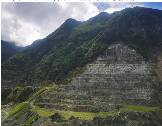
图 47 江咀料场 A 区植被恢复面貌 4
