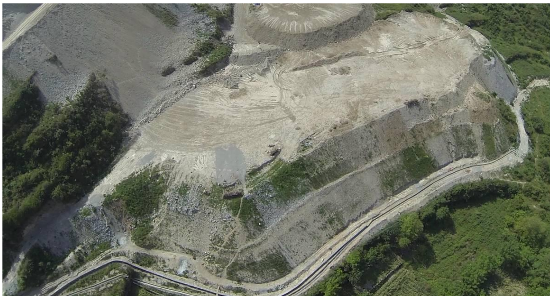
图 13 建设期汤坝料场表土暂存场无人机低空遥感航拍面貌
