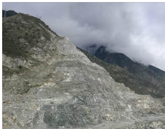
图 42 施工期响水沟料场面貌
