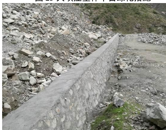
图 27 响水沟渣场挡墙面貌
