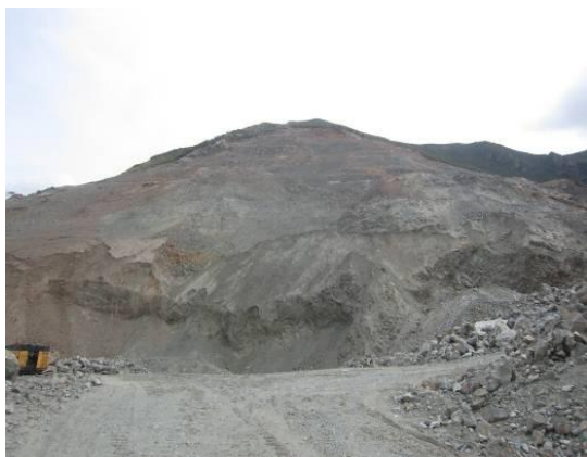
图 49 江咀料场 B 区施工期面貌
