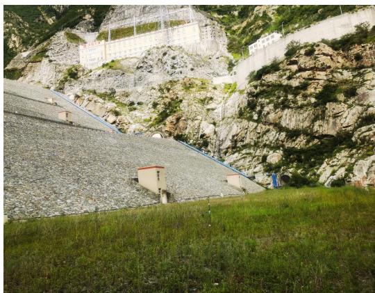
图 25 大坝压重体平台绿化措施
