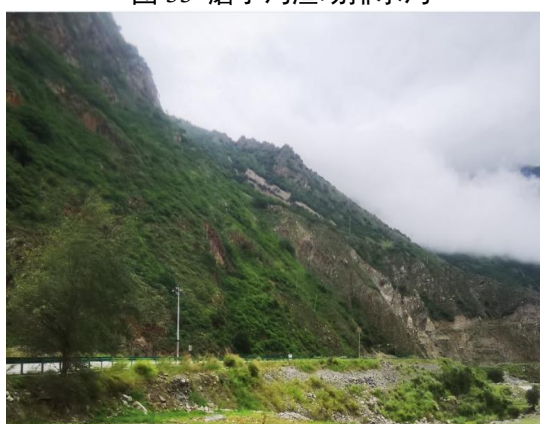
图 35 磨子沟渣场自然恢复边坡
