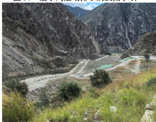
图 32 磨子沟渣场绿化措施 2
