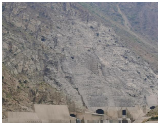
图 26 泄洪洞出口边坡面貌
